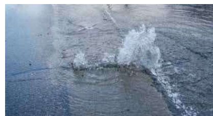
漏水発生:目地部、ネジコミンケットから
