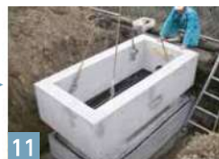
11 側壁部(中間部)据付
