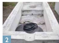
2 吊金具設置状況 2t用カブラ取付
