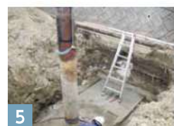
5 掘削後 井戸ケーシング溶断工 井戸径φ350
