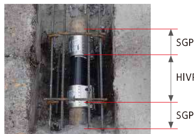
配管修繕作業:HIVPにて接続
