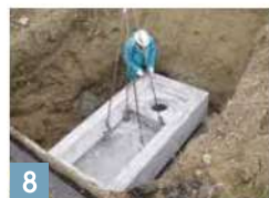
8 底版 据付完了
