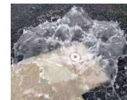
キャップを取り付けたままの排泥 (散水も可能)状況
