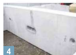
4 側壁部 吊金具用孔
