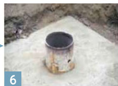
6 井戸ケーシング溶断工 切断完了 ヒット内戻し孔用加工
