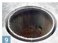
9 底版 据付状況 井戸ケーシングとの設置間隔
