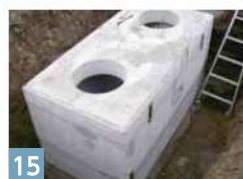
15 頂版部据付工 据付完了 中間部～頂版部連結金具
