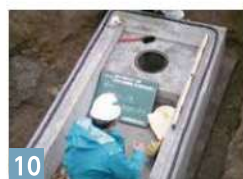
10 底版 据付工 エバシール取付
