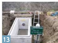
13 側壁部(中間部) 据付工 エバシール取付完了
